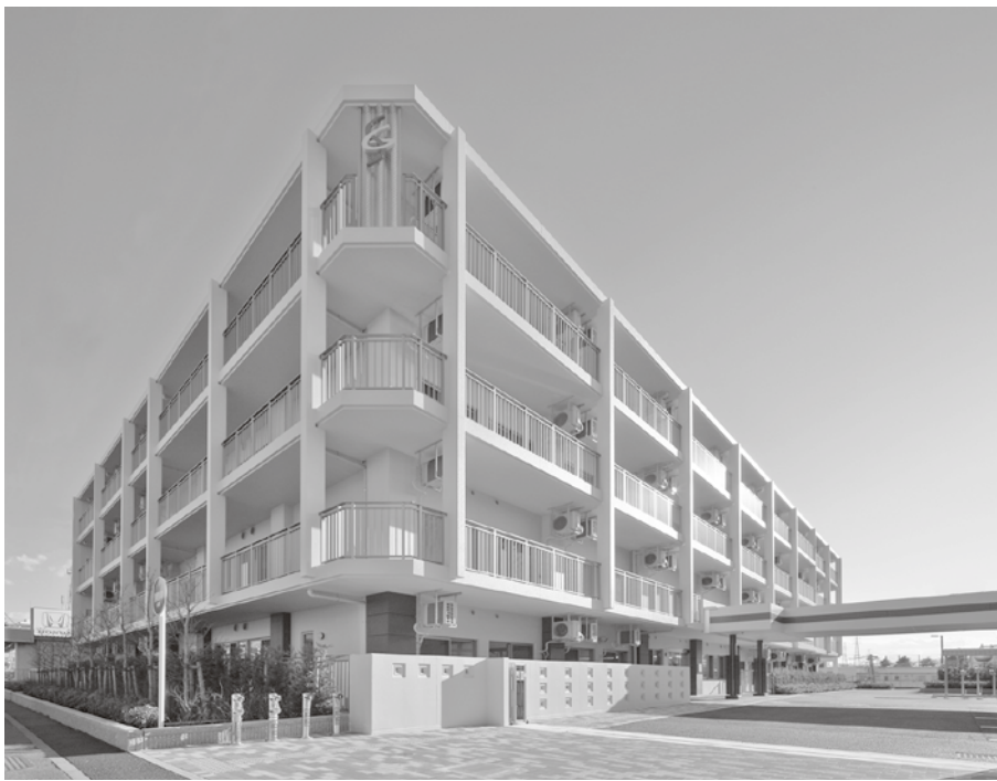
竣工したアウリンコ 北側(甲州街道側)から望む
