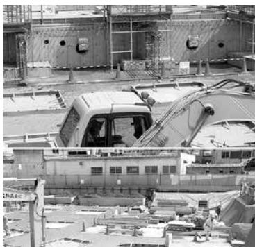
▲基礎工事状況
