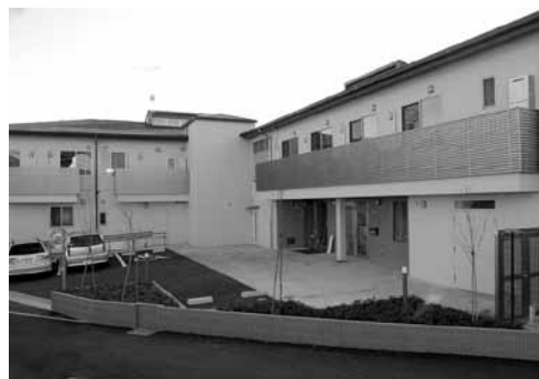
完成した調布若葉ケアセンターの外観
